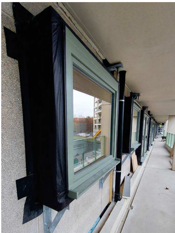
Ce chantier a permis à la Menuiserie Coene de mettre en œuvre une méthode innovante dans la pose de châssis : installer les nouveaux avant de retirer les anciens.
