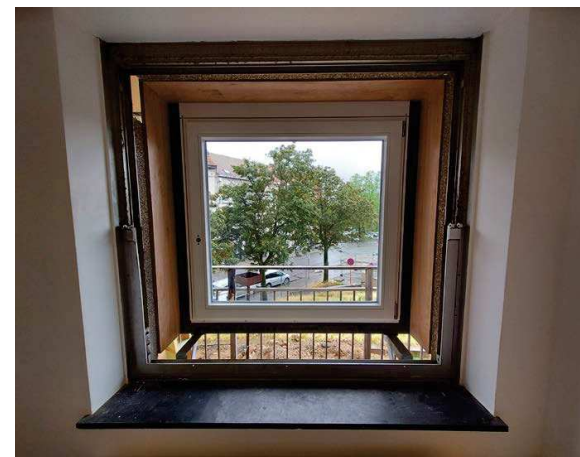
Chaque étape, de l'installation des nouveaux châssis au retrait des anciens, a été pensée pour optimiser le confort des résidents.
